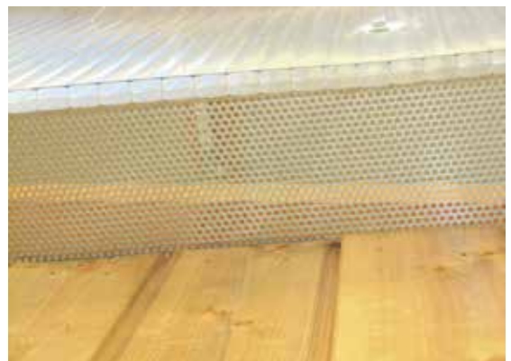
Grille brise-vent sur bardage décalé
